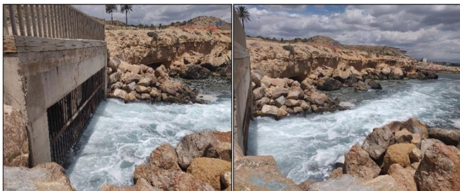
Figura 2.2. Vertido en costa de las SWRO de Alicante I y II en la costa de Alicante (foto tomada por autor)
